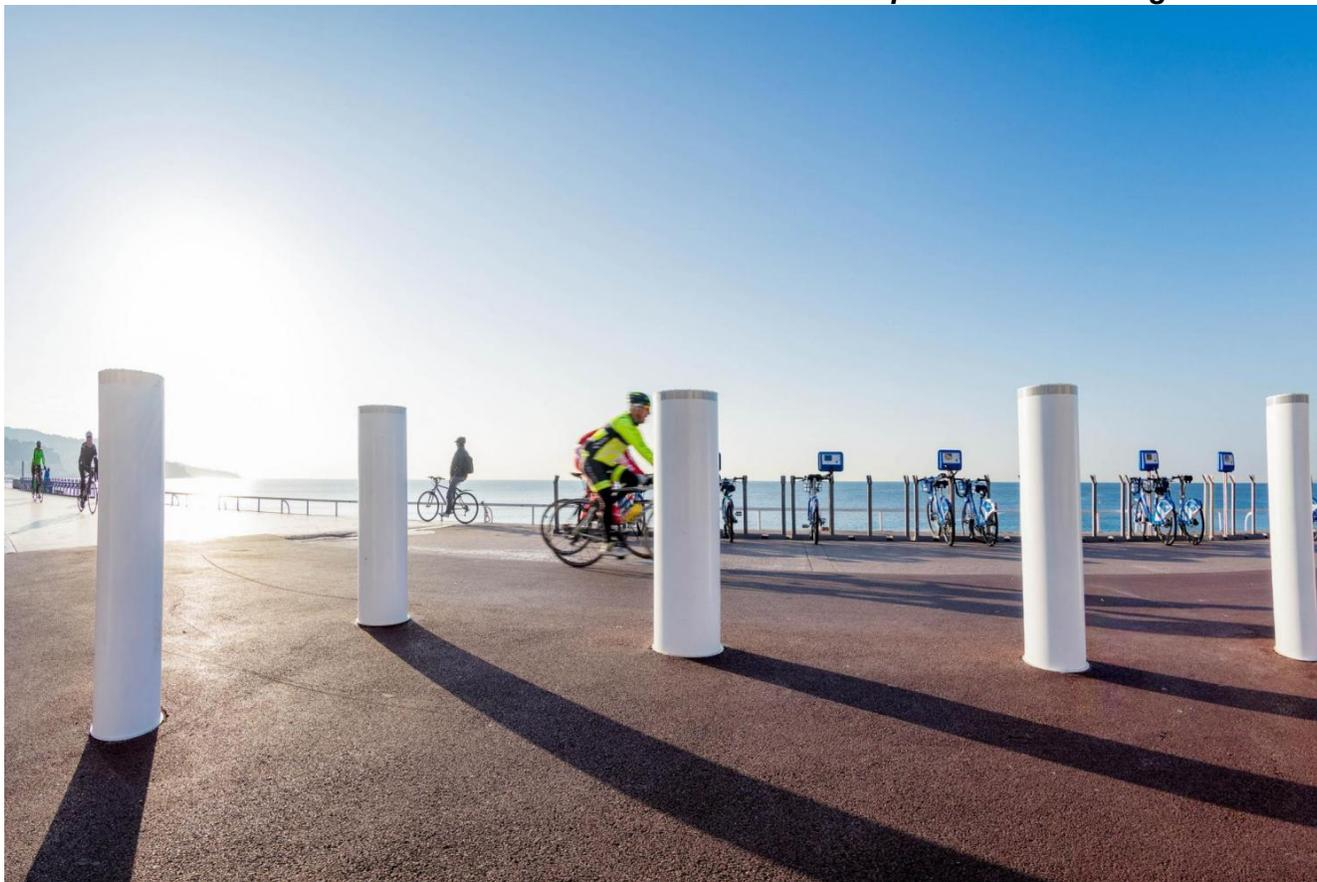
Les bornes crash-testées permettent de résister à l'impact d'un camion de 7,5 T lancé de 48km/h à 80km/h. À Nice, la sécurisation intensive de la Promenade des Anglais a été réalisée par CAME URBACO où des bornes Haute Sécurité ONE40 EVO ont été installées le long de la Promenade des Anglais afin d'assurer une résistance à l'impact d'un camion lancé à 64km/h. Ce projet est fondamental pour la marque qui, par ce lieu symbolique, révèle tout le sens de son activité et de ses produits.
